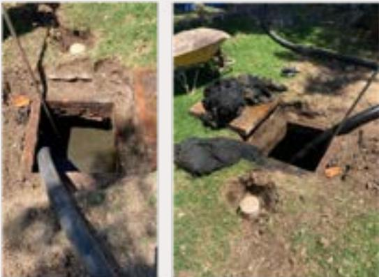
Remoción de materia flotando, mezclado y remoción de materia fecal, en tanque séptico de una vivienda. E. Rosales
